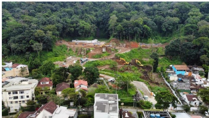
Figura 2 - Execução de contenções
